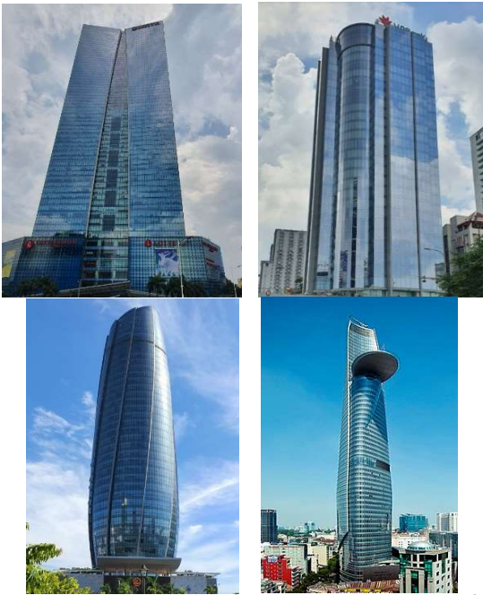
Hình 5. Những ví dụ tiêu biểu cho các công trình cao tầng hiện đại ở Việt Nam sử dụng kính với tỷ lệ rất lớn trên mặt đứng (Lotte Hà Nội, VP Bank Hà Nội, TTHC Đà Nẵng và Bitexco TP. HCM).
