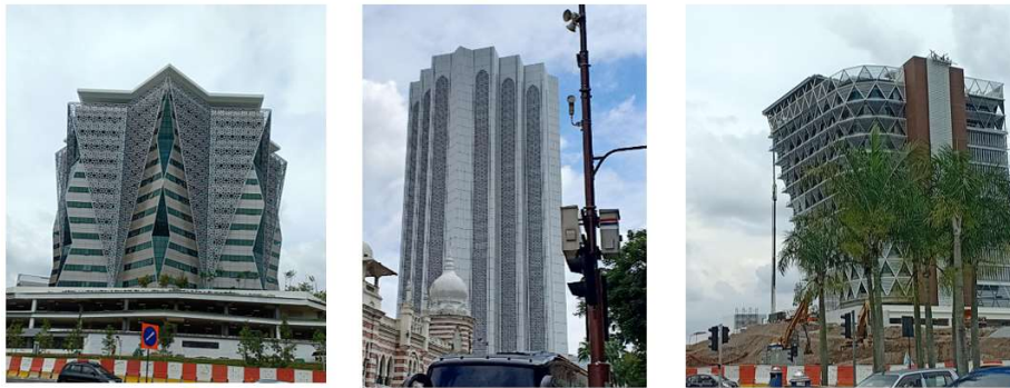
Hình 12. Một số dạng kết cấu che nắng cho tòa nhà văn phòng cao tầng ở Malaysia.
